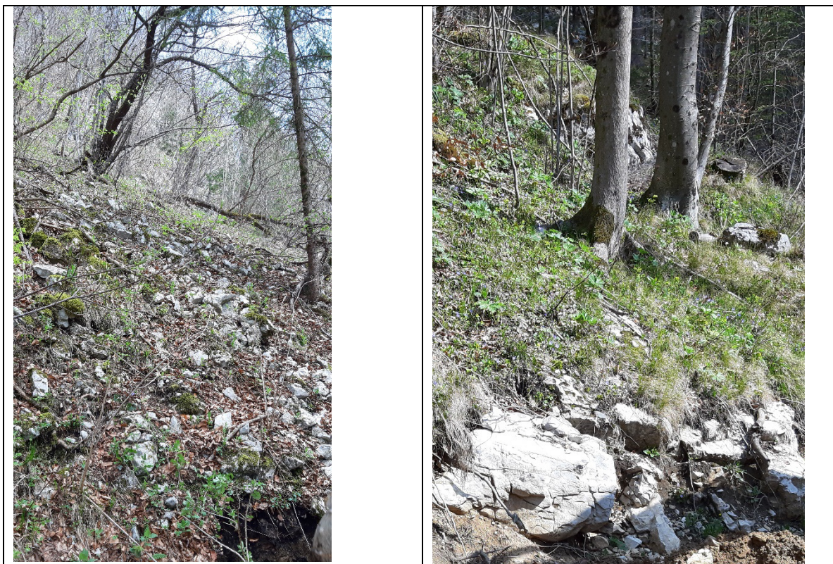
Slika 2 in 3: Pogled na padajoče kamenje v profilu E6-24 do E6-30
